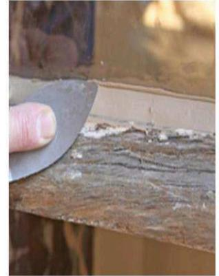
100 - Lisser le mastic de façon continue à l'aide du couteau, puis retirer l'excédent. Araser le contre mastic sur le bord extérieur de la feuillure avec le couteau de peintre placé en appui sur le châssis.
