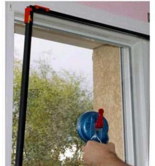
50 - **Mettre** en place le nouveau vitrage avec la ventouse et procéder au **calage**. D'une manière générale, les cales principales seront du côté de la charnière en partie basse et du côté opposé de la charnière en partie haute.
