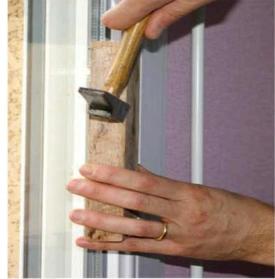
Remettre les parecloses dans l'ordre **inverse**..... de la dépose (terminer par une parclose dans le sens de la plus grande dimension de la fenêtre).
