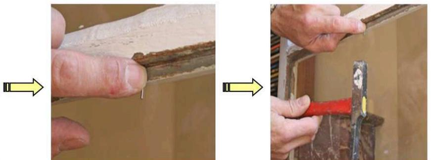
80 - Clouer en priorité le **haut** du châssis, puis le bas et terminer par les côtés. Il est impératif que les pointes de vitrier (clous sans tête) ne **dépassent** la feuillure car elles risqueraient de gêner lors de l'application du mastic.
