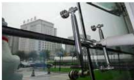
Le vitrage est percé afin de recevoir les agrafes
