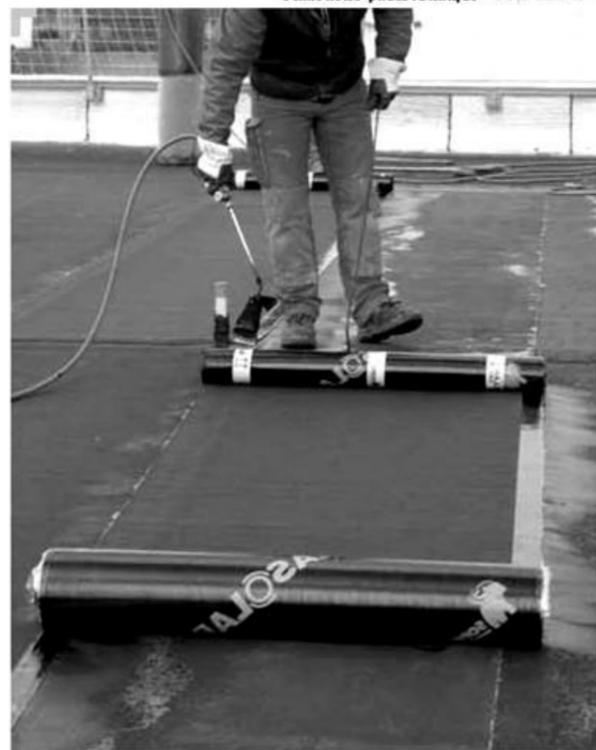
Application de Soprasolar® Cap, 2<sup>ème</sup> couche silicie auto-protégée
