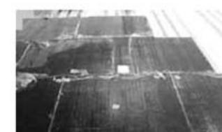
Pose de l'isolant de classe C fixé mécaniquement.
