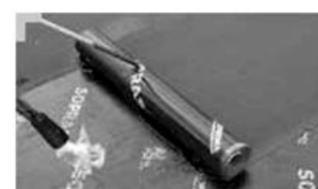
Pose de la 2<sup>ème</sup> couche d'étanchéité, le Soprasolar® Cap (lés de 6 m x 1 m). Pose à joint décalé de 25 cm.
