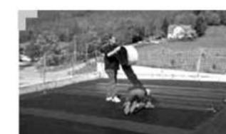
Collage de la cellule, puis mise en place d'un cordon Sopramastic 200 en tête de cellule.
