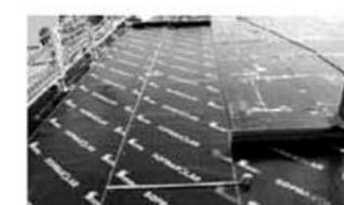
Pose 1<sup>ère</sup> couche d'étanchéité, le Soprasolar® Base (lés de 10 m x 1 m). Mise hors d'eau réalisée.
