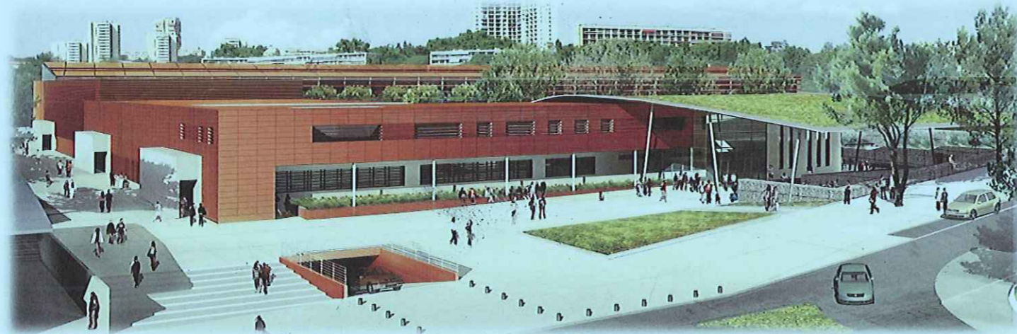
Construction du lycée la Fourragère - Marseille
