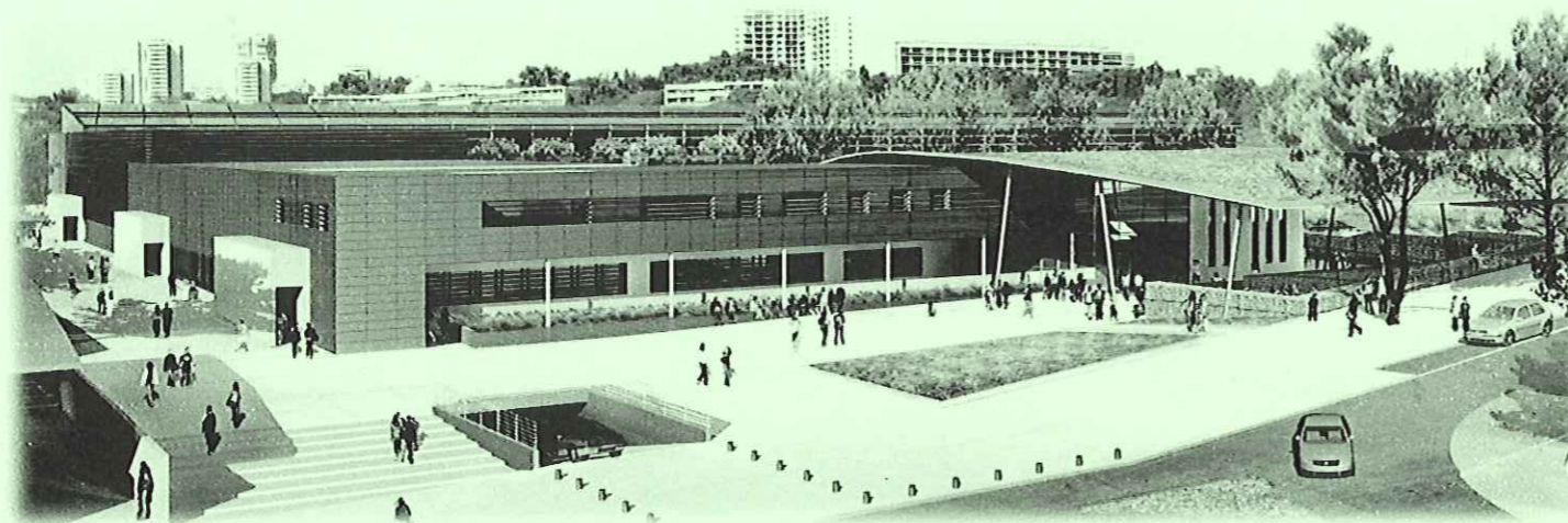
Construction du lycée la Fourragère – Marseille
